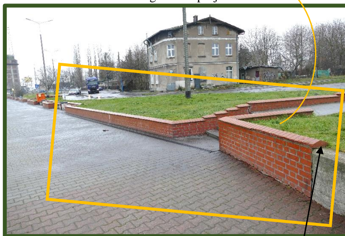
13,14. Zachodnie nabrzeże Martwej Wisły i części portowej (w pobliżu wschodniej granicy cmentarza). Współczesne, ceglane i betonowe elementy cokołowe, schody i nawierzchnie wytypowane do wymiany, zgodnie z projektem.
