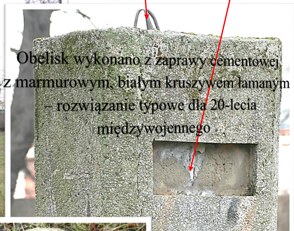
11. Zbliżenie na miejsce po tabliczce(?) Kotwa stalowa po brakującej części szczytowej obelisku.
