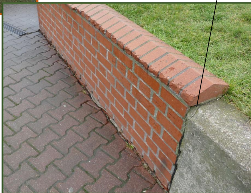
15. Fragment murka oporowego i betonowego chodnika – elementy współczesne, zniszczone, projektowane do wymiany.
