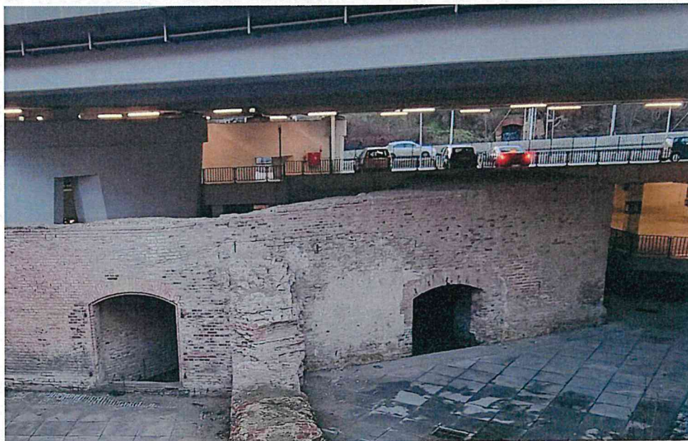
Rys. 29 Wschodnia ściana poterny z wejściem (po lewej) i furtką wodną F (po prawej stronie)
