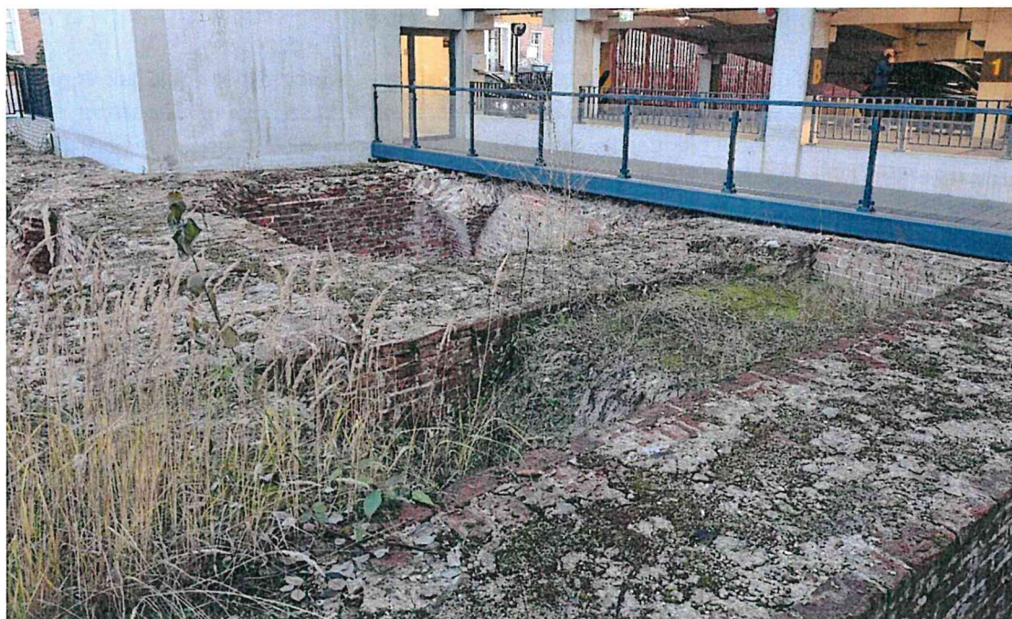
Rys. 27 Widok na korony muru wartowni, widoczna degradacja górnych warstw cegieł i postępująca ekspansja roślinności ruderalnej (trawy, rośliny zielne i mchy)
