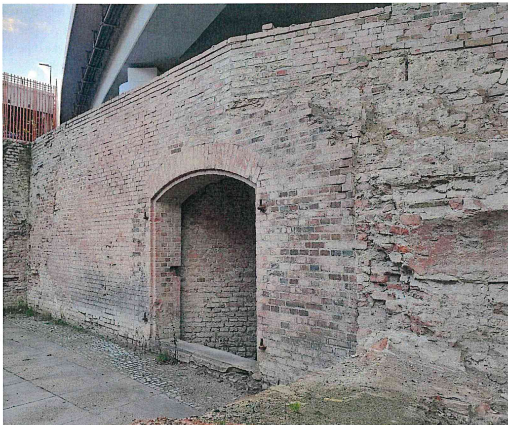
Rys. 36 Wschodnie wejście do poterny
