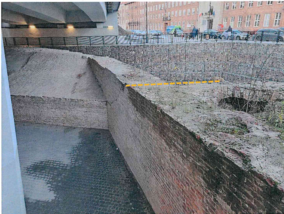
Rys. 17 Zasięg pęknięcia – wyraźnie widoczna granica związana z filarem kazamaty K
