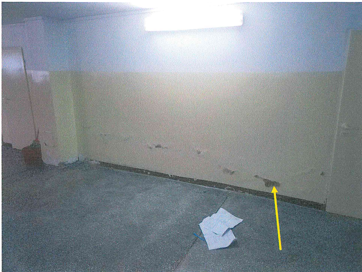
Fotografia nr 1: Zawilgocona ściana wewnętrzna (blok B- piwnica) na skutek przecieku z instalacji odprowadzającej wodę z dachu. Konieczne jest usunięcie tynku na wysokości 70cm ponad poziom posadzki. Zaleca się zastosowanie tynków renowacyjnych ze względu na obecność soli na murze. Występowanie zawilgocenia zaznaczono na załączonym rzucie. Strzałką zaznaczono miejsce pobrania próbki do badań mykologicznych (próbka nr 1/11/19).
