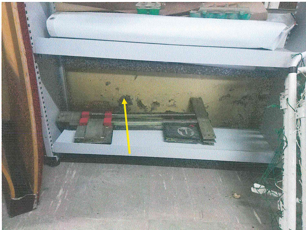
Fotografia nr 4: Zawilgocenie ściany spowodowane uszkodzeniem izolacji wodochronnej (pomieszczenie przy sali gimnastycznej). Konieczne jest usunięcie tynków. Zaleca się zastosowanie tynków renowacyjnych ze względu na obecność soli na murze. Występowanie zawilgocenia zaznaczono na załączonym rzucie. Strzałką zaznaczono miejsce pobrania próbki do badań mykologicznych (próbka nr 2/11/19).
