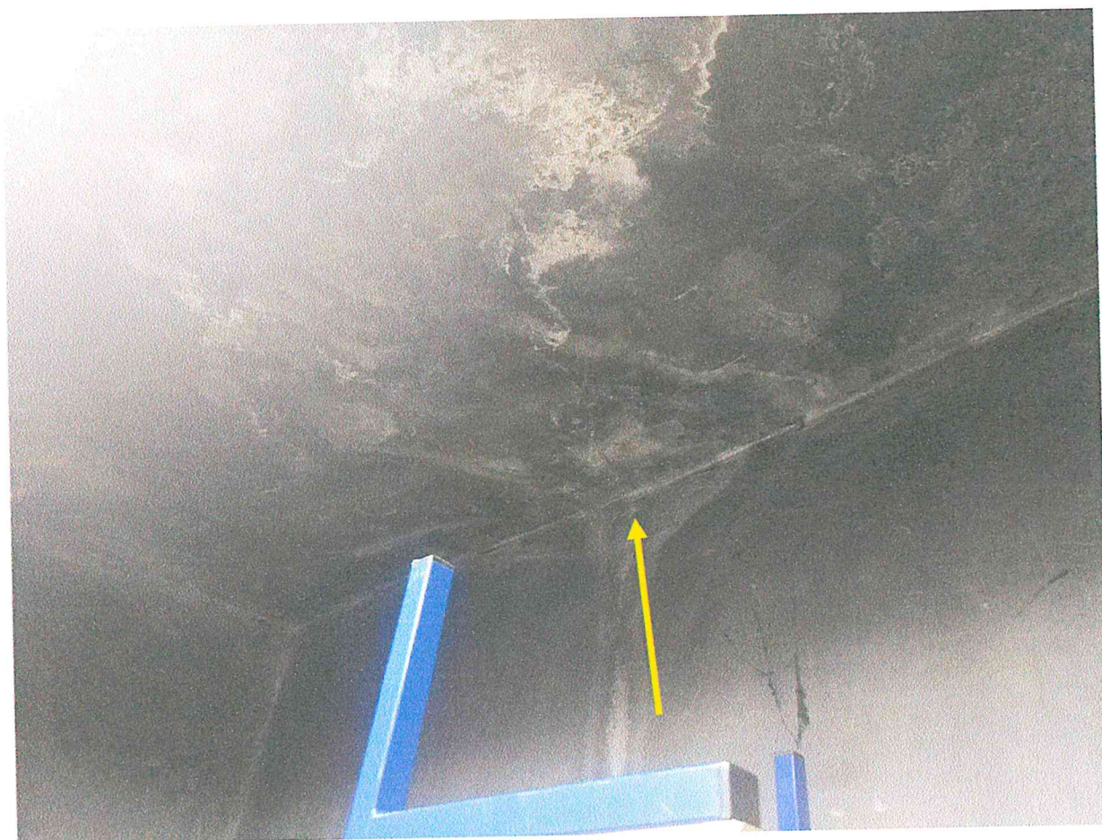
Fotografia nr 6: Pomieszczenie w narożu budynku pod salą gimnastyczną. Ściany i sufit zawilgocone na skutek uszkodzenia izolacji wodochronnej. Zaleca się zastosowanie tynków renowacyjnych ze względu na obecność soli na murze. Występowanie zawilgocenia zaznaczono na załączonym rzucie. Strzałką zaznaczono miejsce pobrania próbki do badań mykologicznych (próbka nr 3/11/19).
