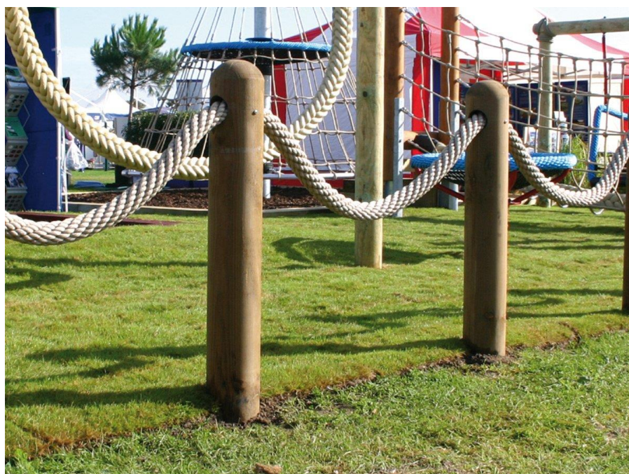
Fot. nr 1 Propozycja mocowania lin w słupkach
