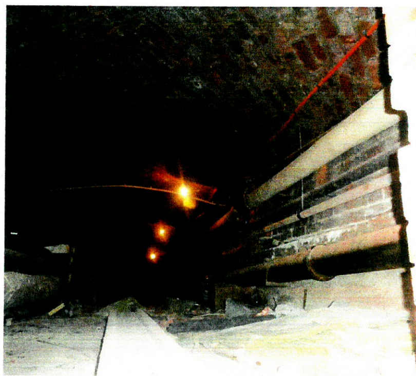
Istniejąca instalacja hydrantowa w korytarzu piwnicznym
